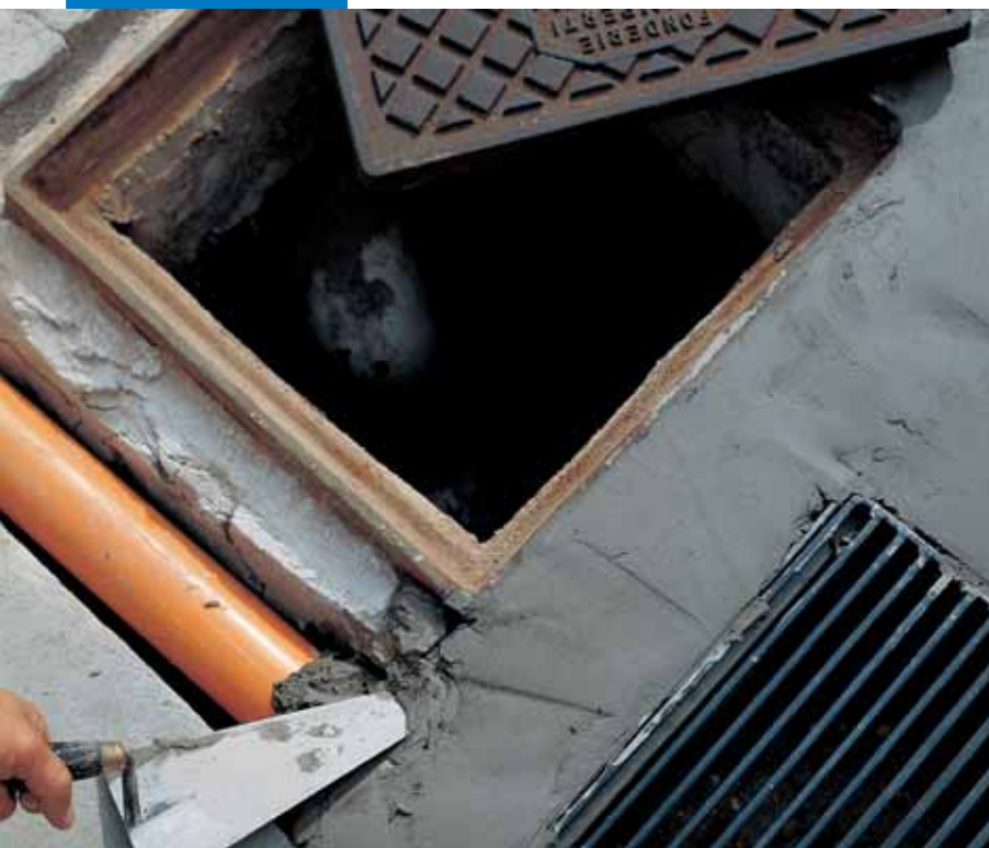
Pose de canalisations et de regard d'écoulement avec Lampocem
