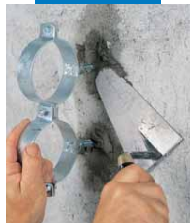
Fixation de colliers pour canalisation avec Lampocem
