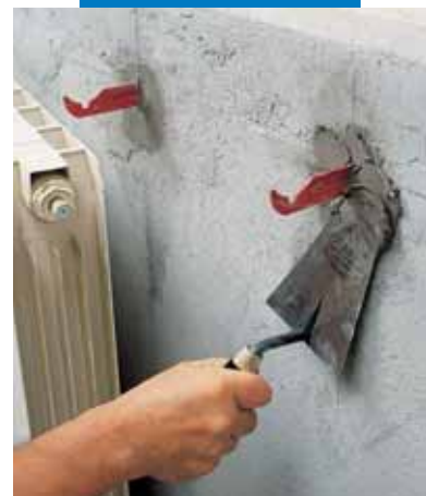
Fixation de supports pour radiateur avec Lampocem
